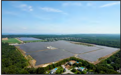
Shoreham Solar Commons (25 MW) Brookhaven, New York
